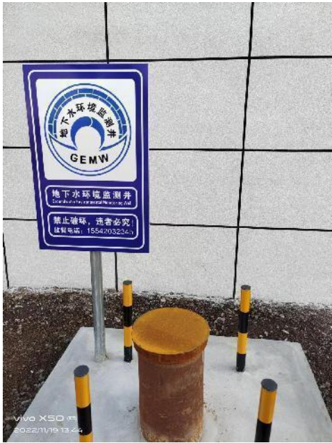
地下水监测井
