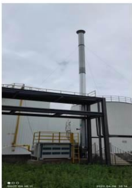
DA002 储罐区排气筒
