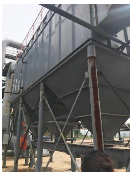
焚烧废气措施（SNCR 脱硝+急冷塔+干法脱酸+布袋除尘器+湿式脱酸洗涤）
