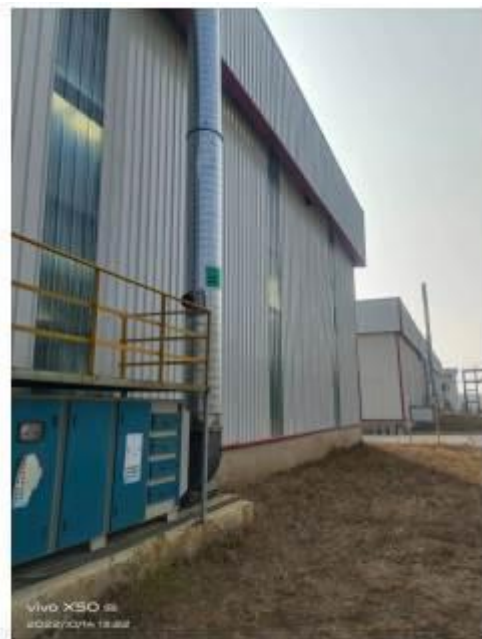
DA005 污水处理站排气筒
