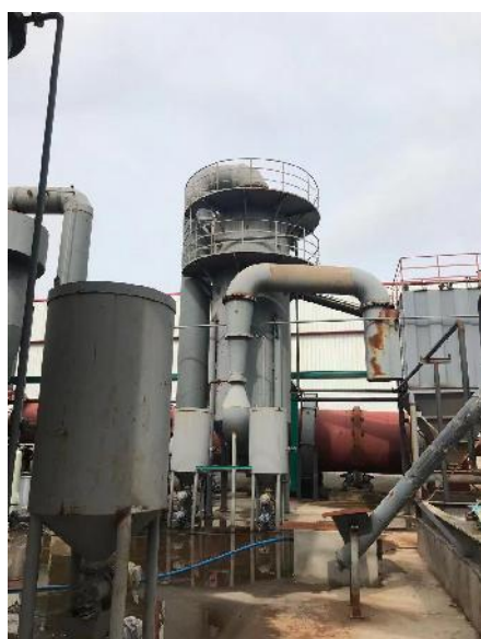
焚烧废气措施（SNCR 脱硝+急冷塔+干法脱酸+布袋除尘器+湿式脱酸洗涤）
